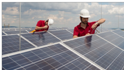
EVN nahm im September Photovoltaikanlagen mit einer Leistung von 300 MW in Betrieb.
